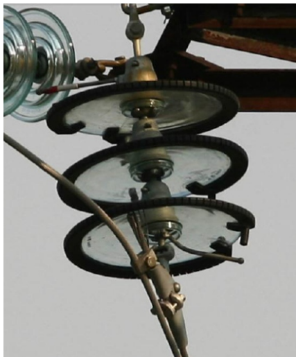
Рисунок 11 - Перекус зажима с касанием проводом ребра нижнего ИРМК
